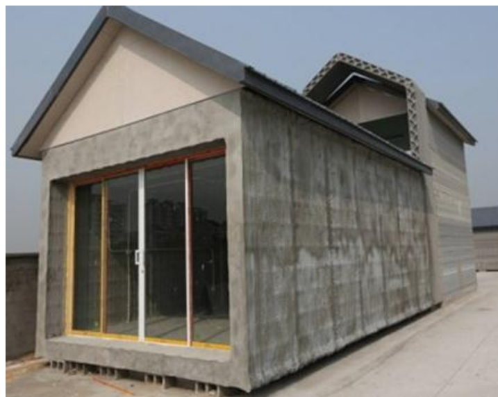
Рис. 1.7. Дом, построенный с помощью 3D-принтера
